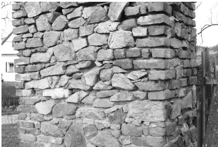
Pilíř ze smíšeného zdiva ztužený cihlami v rozích
