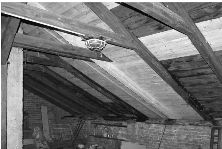
Nově vyměněná prkna a krokev
