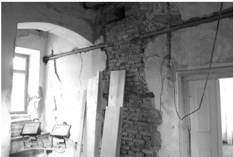
Dodatečně vložené táhlo ztužující protilehlé stěny objektu
