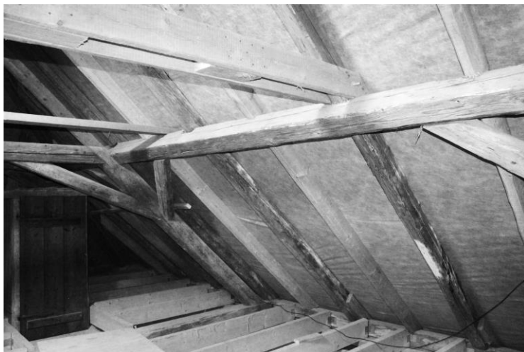
Nově vložené krokve a kleštiny, které zvyšují únosnost krovu
