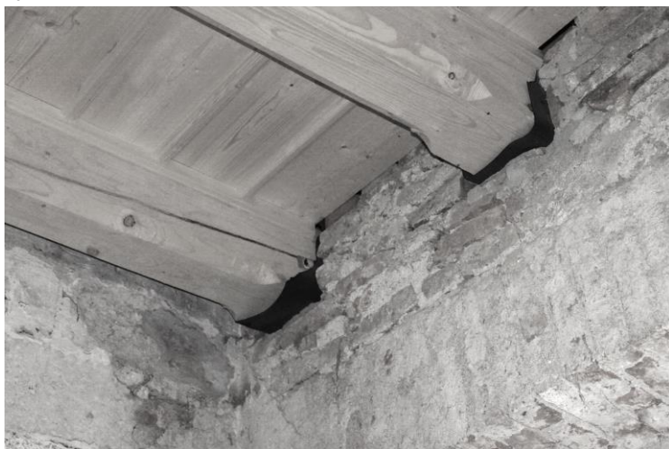
Nový trámový strop uložený ve zdivu se zhlavím chráněným asfaltovou lepenkou
