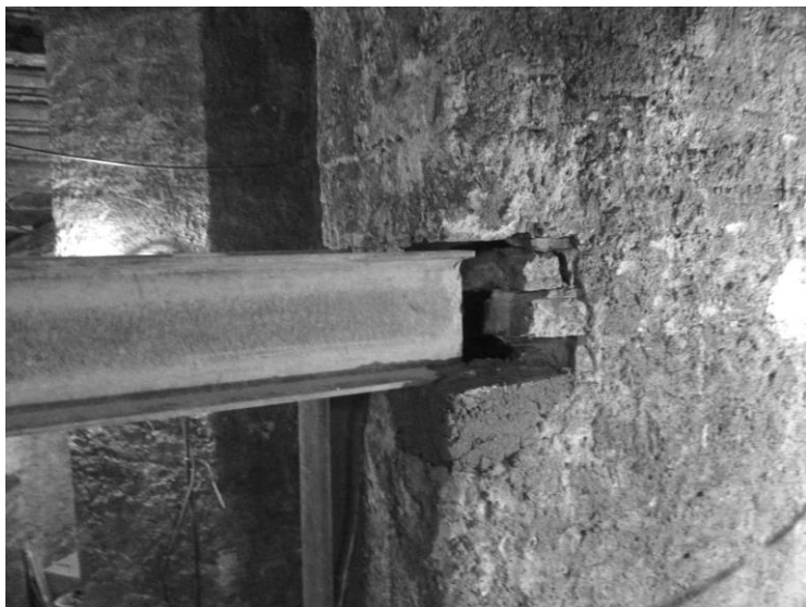
Nově vložený ocelový překlad uložený na vybetonovaném polštáři ve zděné stěně.
