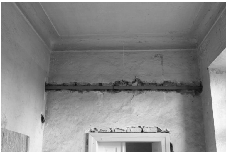
Dodatečně vložené táhlo ztužující protilehlé stěny objektu
