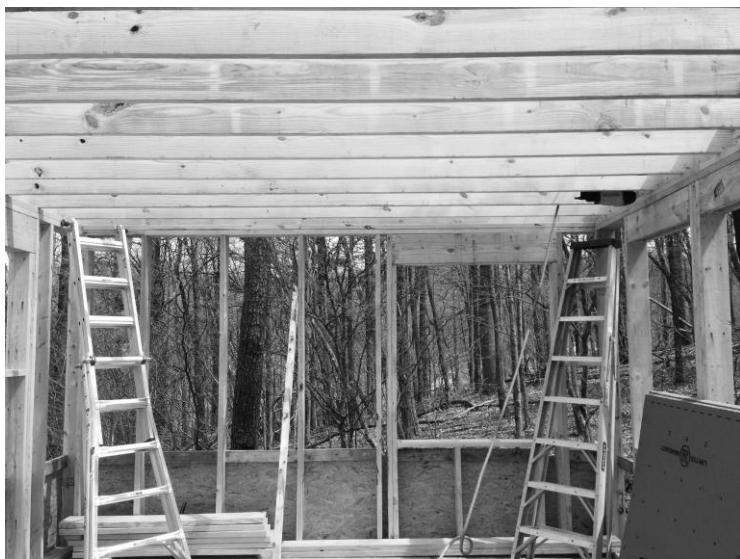
Fošnový strop typický pro moderní dřevostavby
