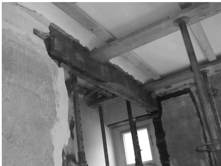
Vložený keramický překlad v nově vybouraném otvoru ve zděné stěně.
