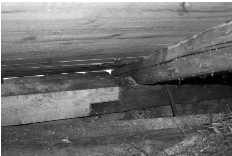
Nastavení staré pozednice přeplátováním
