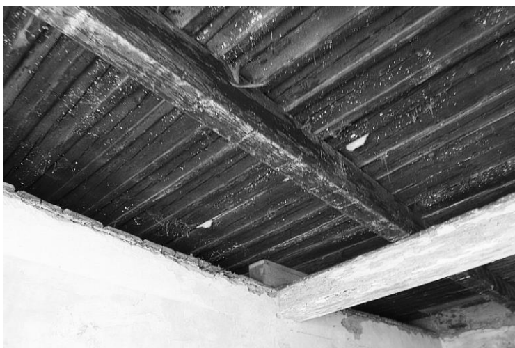
Trámový povalový strop
