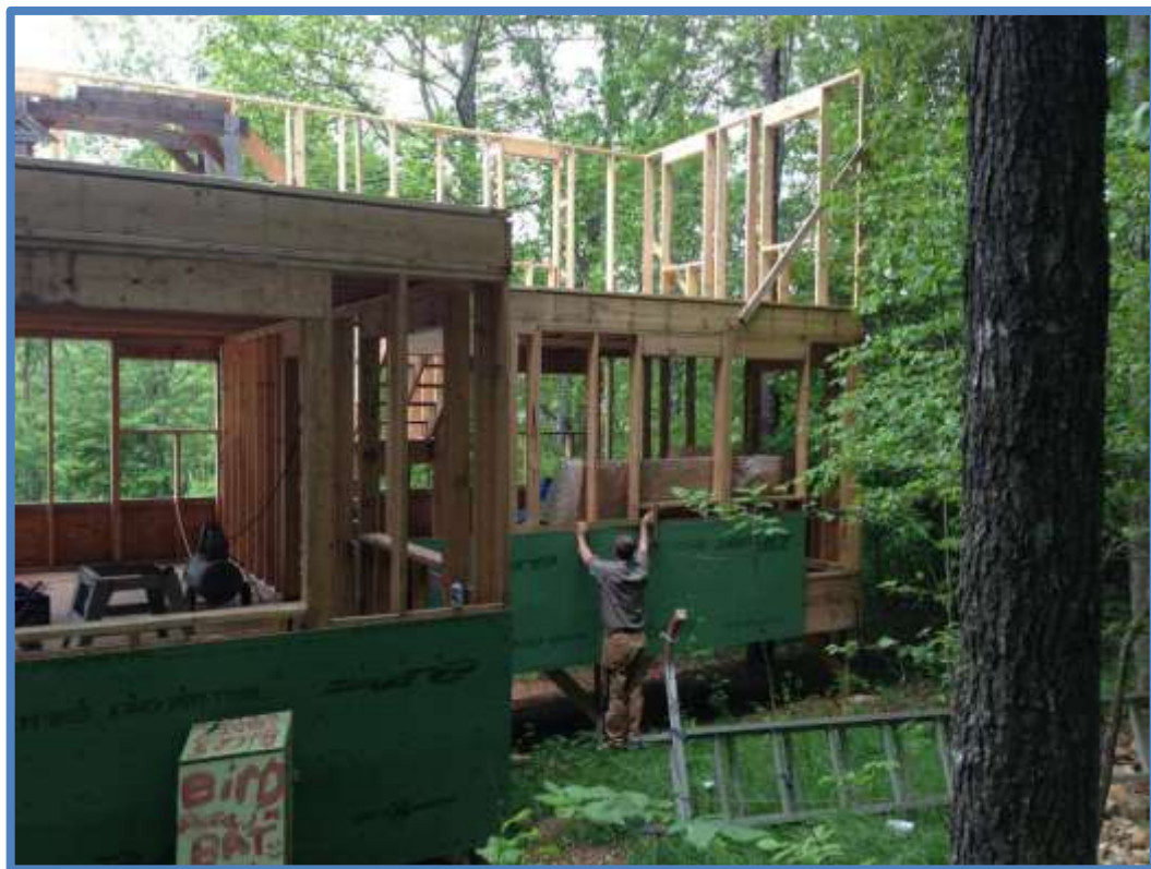
Stavba nového domu v blízkosti dočasného mini-domku
