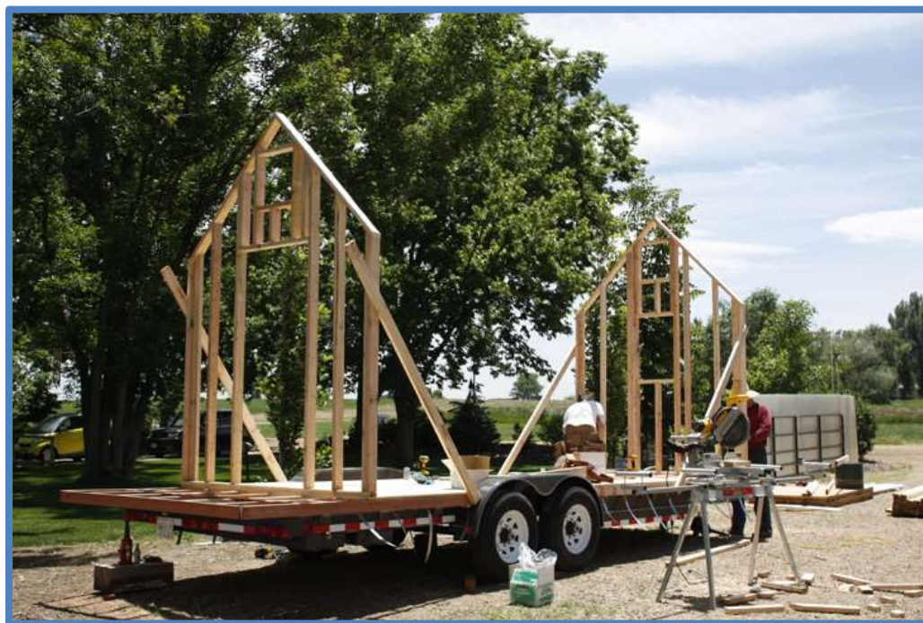
Práce na hlavní nosné konstrukci domu
