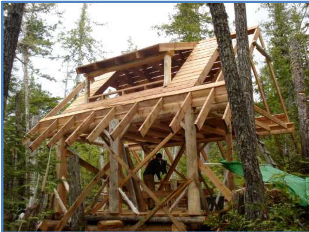
Stavba nosné konstrukce domu
