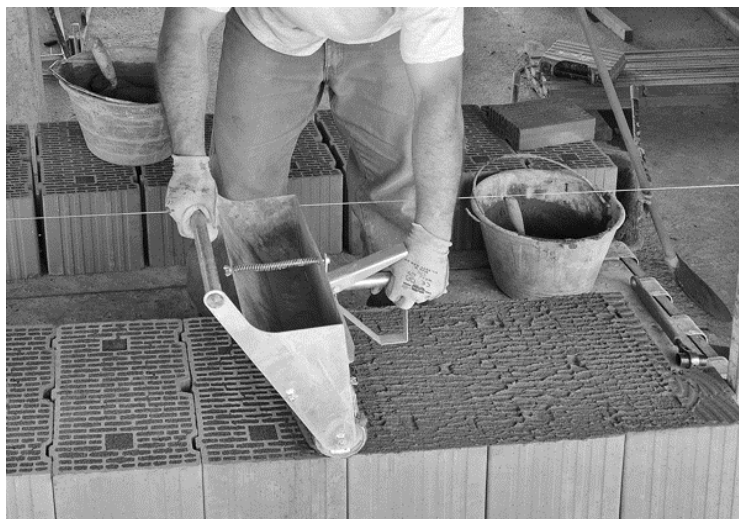
Zdění z keramických bloků na lepidlo
