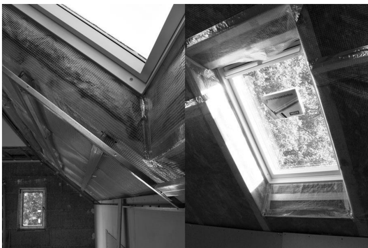
Střešní okna před instalací podkrovního podhledu
