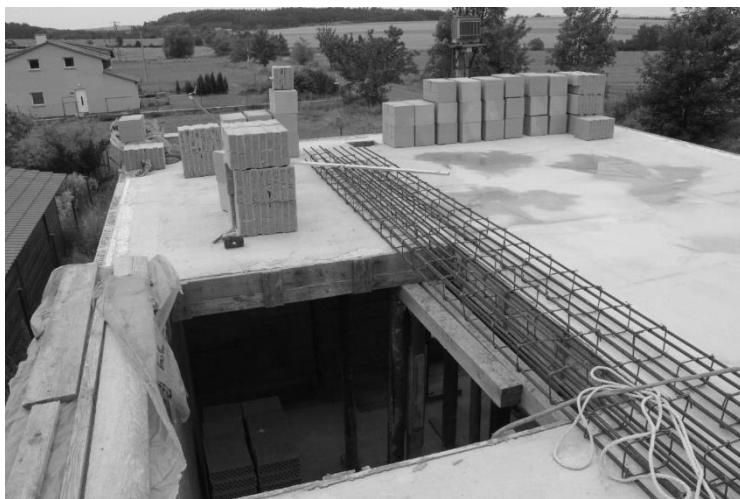
Pohled na strop ze shora. Na obrázku je připravena výztuž do železobetonového věnce pod budoucí pozednicí.
