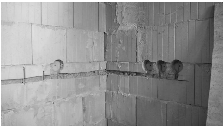
Připravené drážky pro elektro- kabely, vstupy, vypínače
