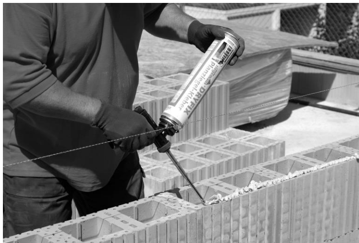
Zdění z keramických bloků na lepicí pěnu
