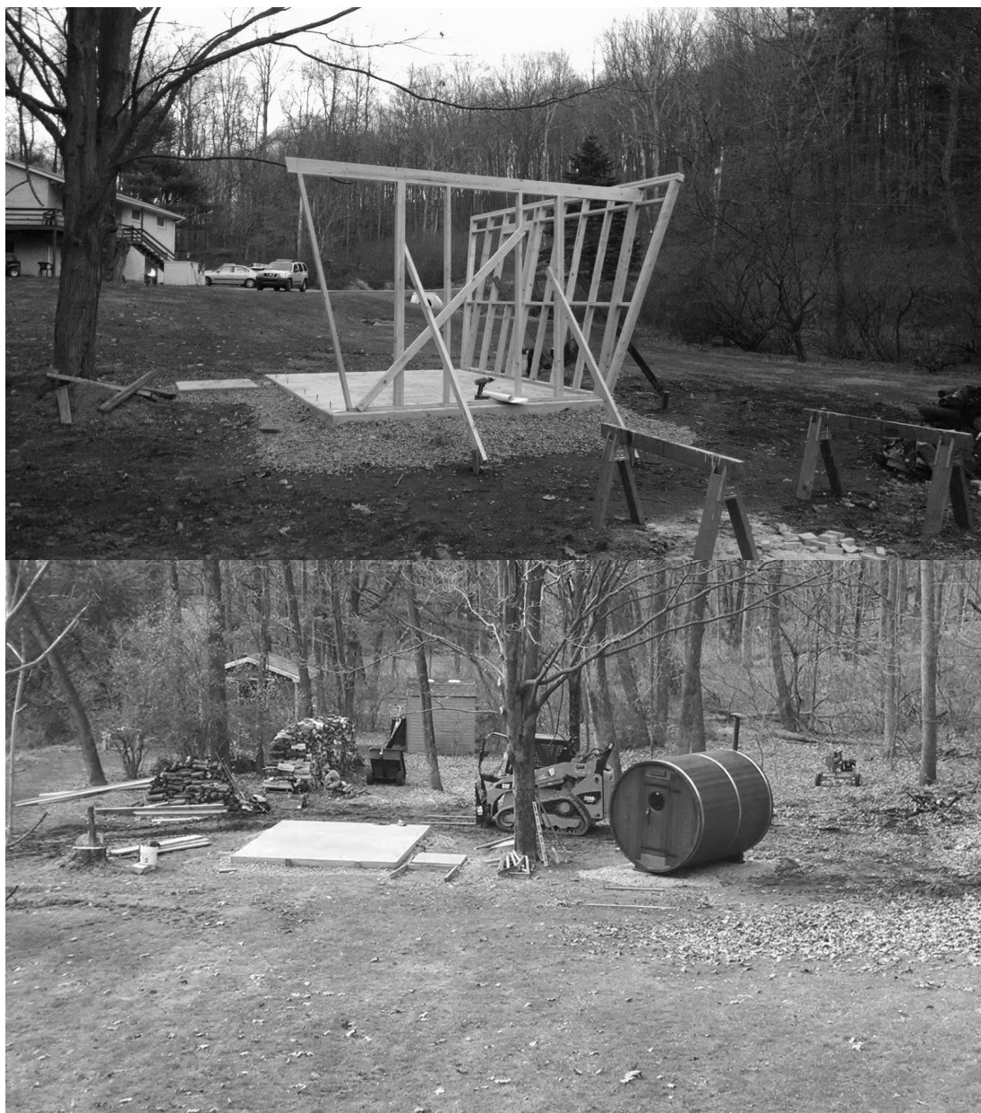
Založení na betonové desce - Ann; Východní Pensylvánie
