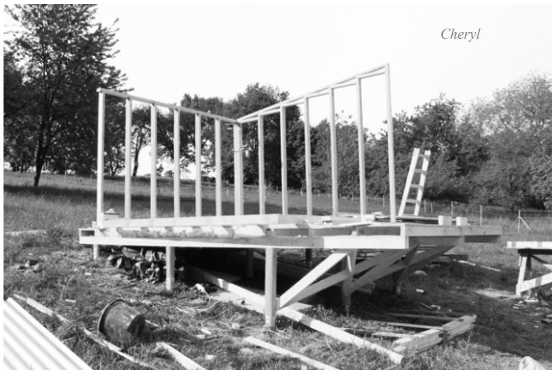
Vztyčení prvních dvou stěnových rámu
