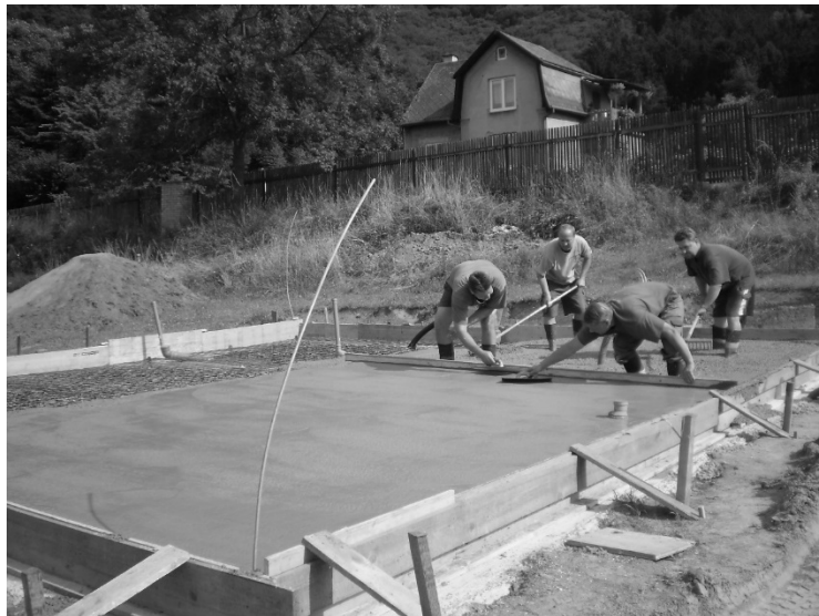
Příprava rovné betonové plochy pro budoucí hydroizolaci
