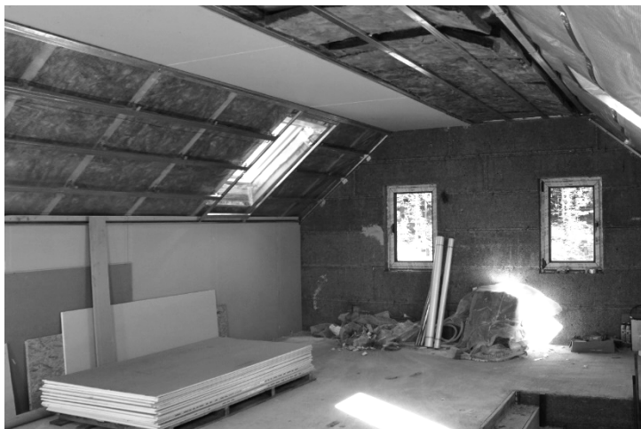
Montáž sádrokartonu v různých fázích
